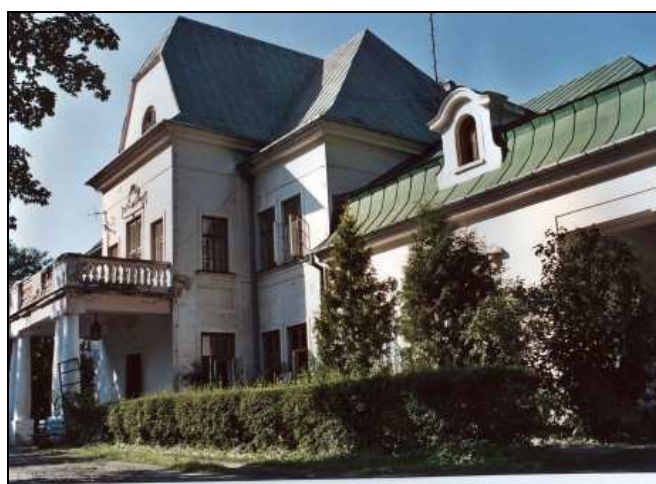
Fotografia 4 – Pałac Dworski w Łysołajach – Kolonii
